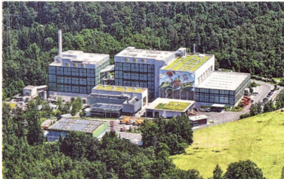
Die IG Fernwärme übt harsche Kritik an künftig deutlich höheren Preisen für die Abwärme des Restmüllheizkraftwerks (RBB). Dagegen wehrt sich der Zweckverband RBB.
